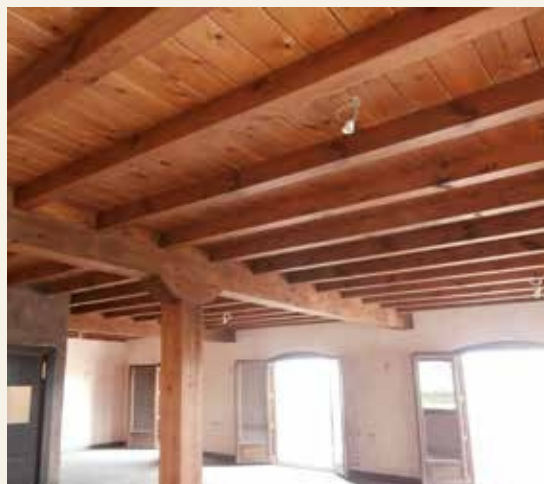
VIGAS Y FRISO DE MADERA MACIZA
